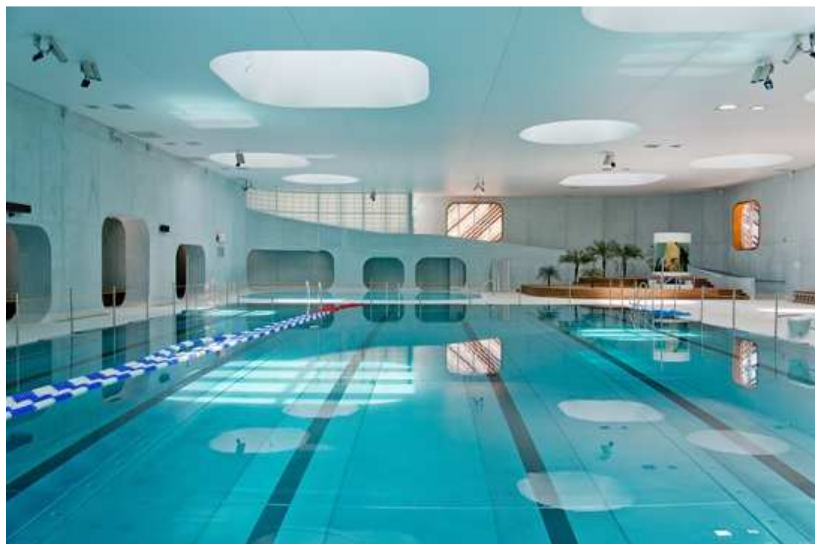
Systeme Poséidon à Aquazena - Issy les Moulineaux
